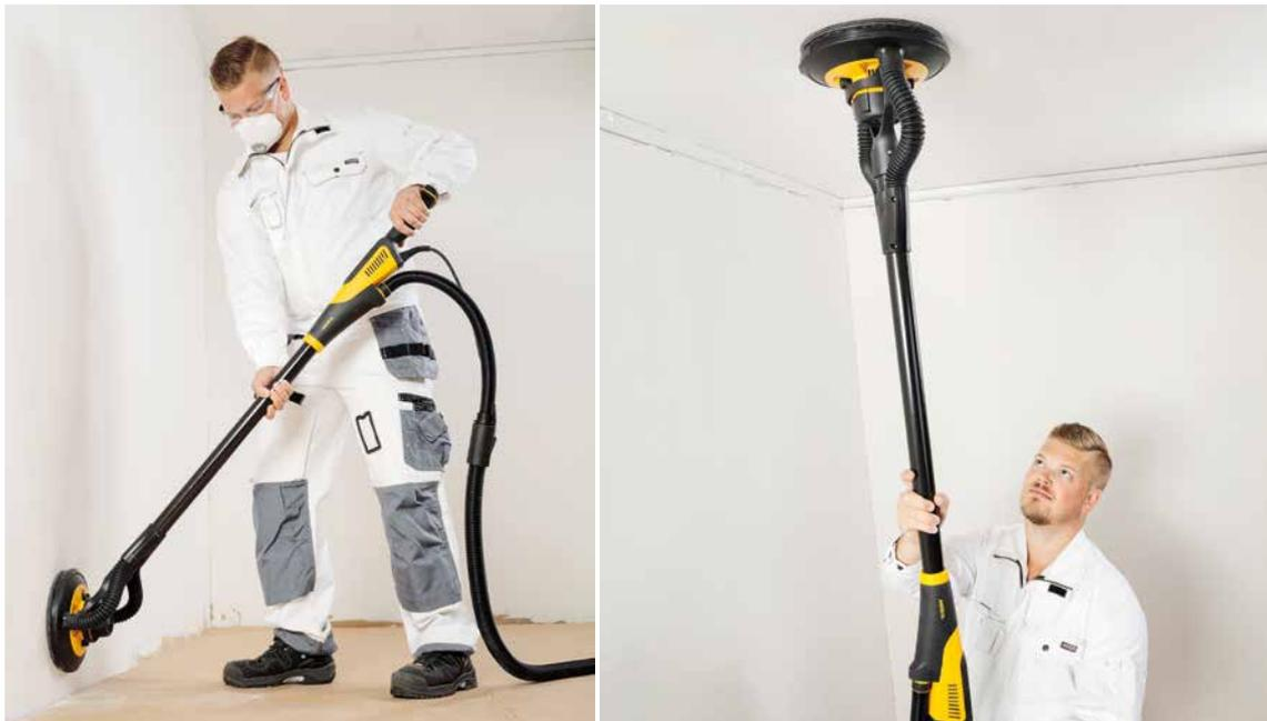
Bei grossen gespachtelten Flächen empfehlen wir Ihnen die Nutzung des Wand- und Deckenschleifers Mirka LEROS. Dieser ermöglicht Ihnen ein rationelles und staubfreies Arbeiten, sowie gleichmässige Oberflächen in kürzester Zeit. Durch den Einsatz von Abranet P80 bis P320 statt konventionellen Schleifscheiben, wird die Schleifleistung spürbar erhöht und die Arbeitsumgebung gleichzeitig sauber gehalten.
